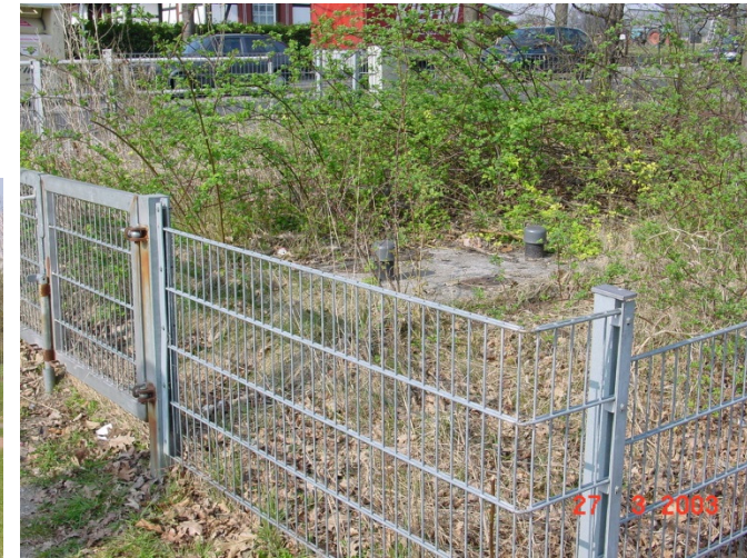
Standort rückgebaute Absauganlage
